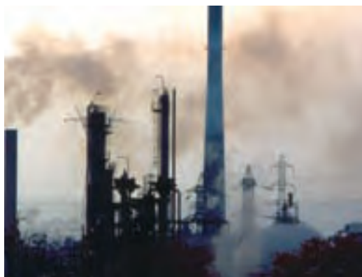
Fig. 3 - Sphère de gaz de pétrole liquéfié et unité de craquage de pétrole dans une raffinerie.
