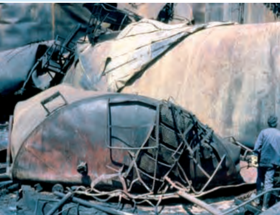
Fig. 11 - Bac d'hydrocarbure après une explosion interne
